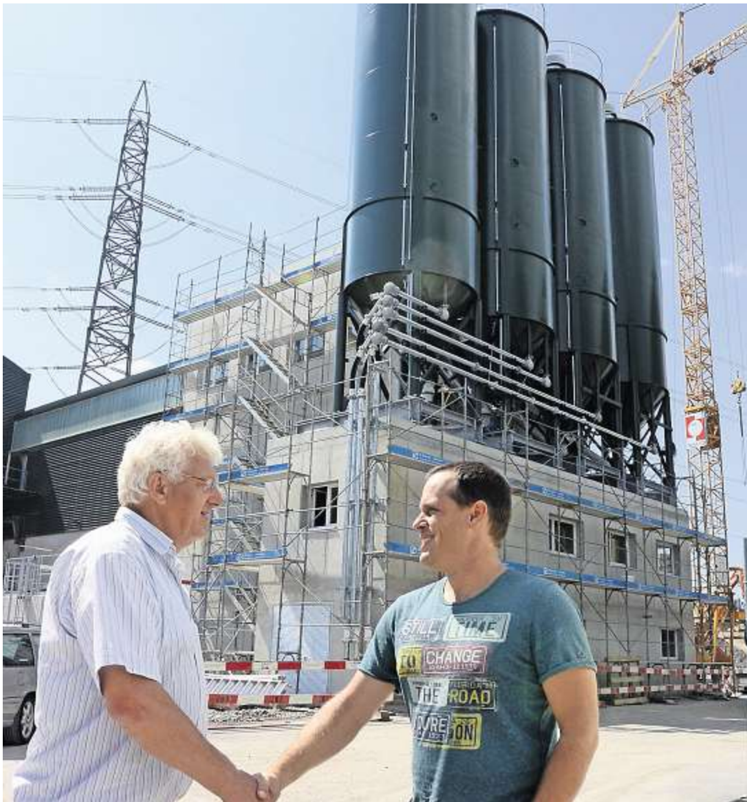
Josef Schwager (rechts) und Martin Jud von der JMS freuen sich gemeinsam an der Aufrichte über das gelungene Betonwerk.
