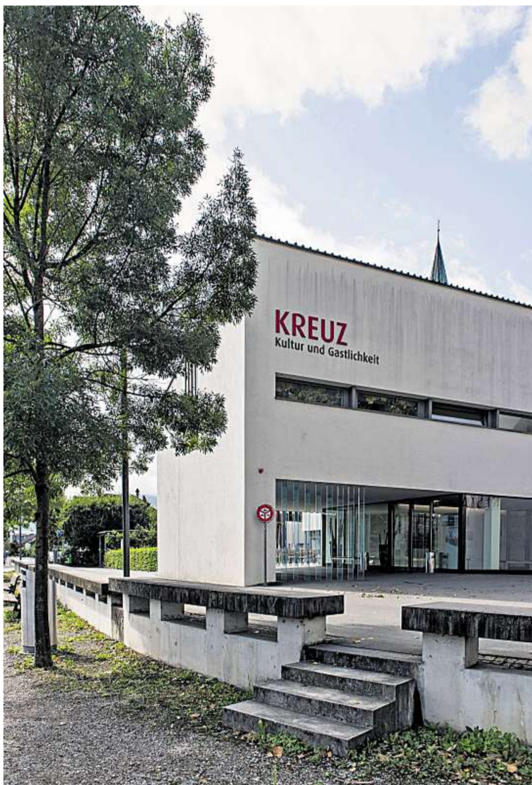
Eine Studie schlägt vor, anstelle des Kreuzes etwas ganz Neues im Zentrum von Jona zu bauen.
