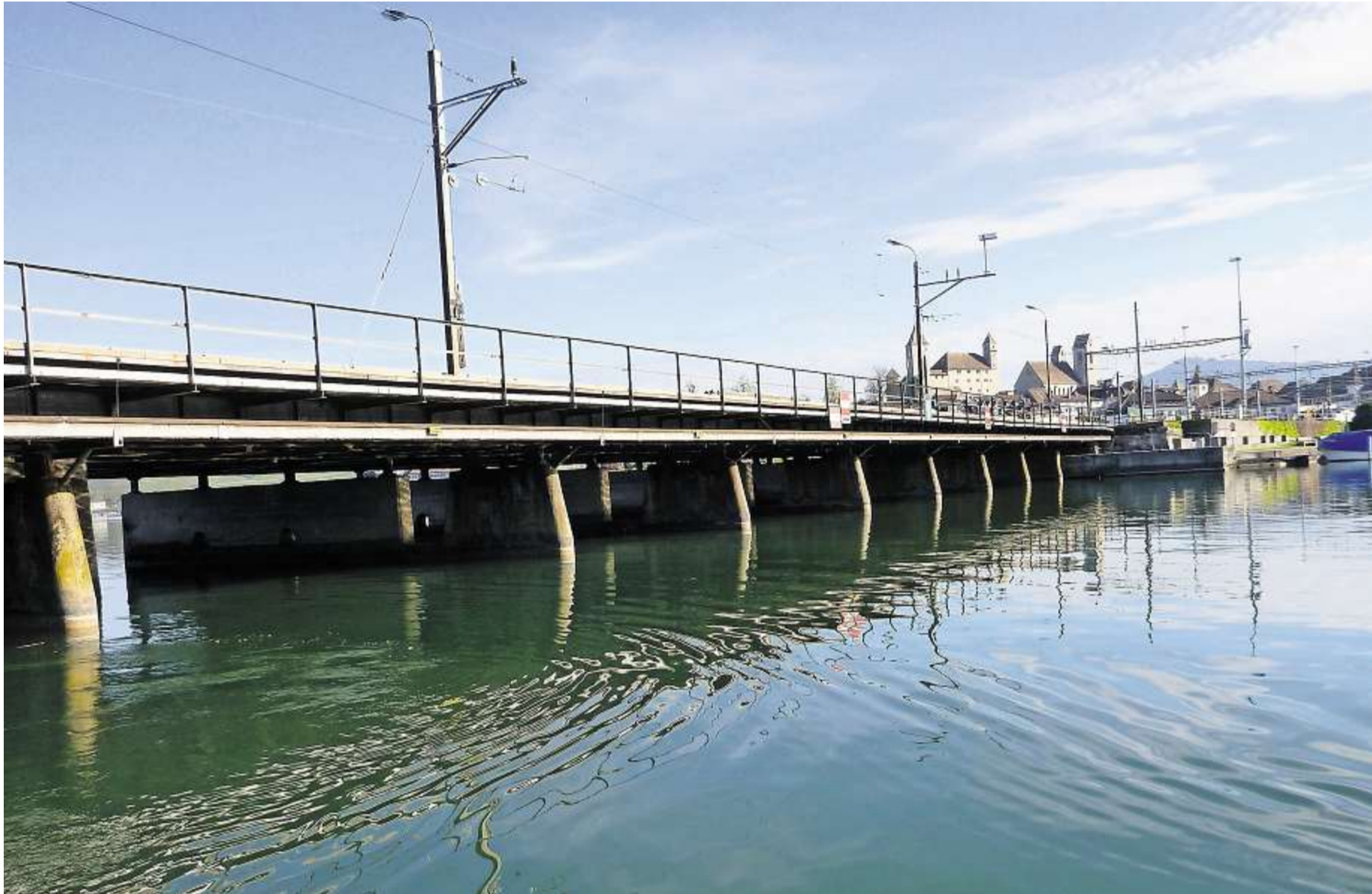
Die 1943 gebaute Brücke zwischen Hurden und Rapperswil muss saniert werden. Deshalb wird im Sommer an zwei Wochenenden die Brücke komplett gesperrt.
