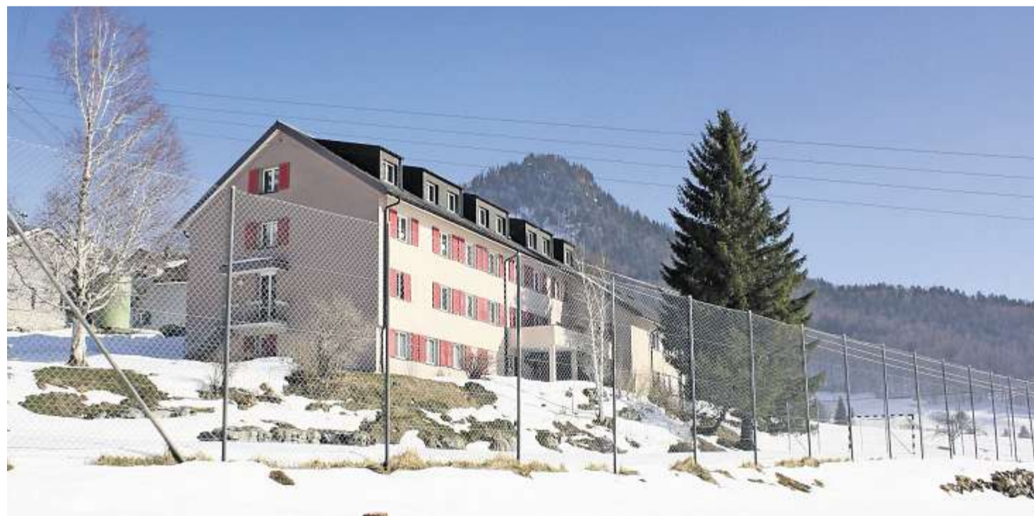
Mit Ausnahme kleiner Arbeiten bleibt die Gebäudehülle des Schwendihauses in Amden im heutigen Zustand.
