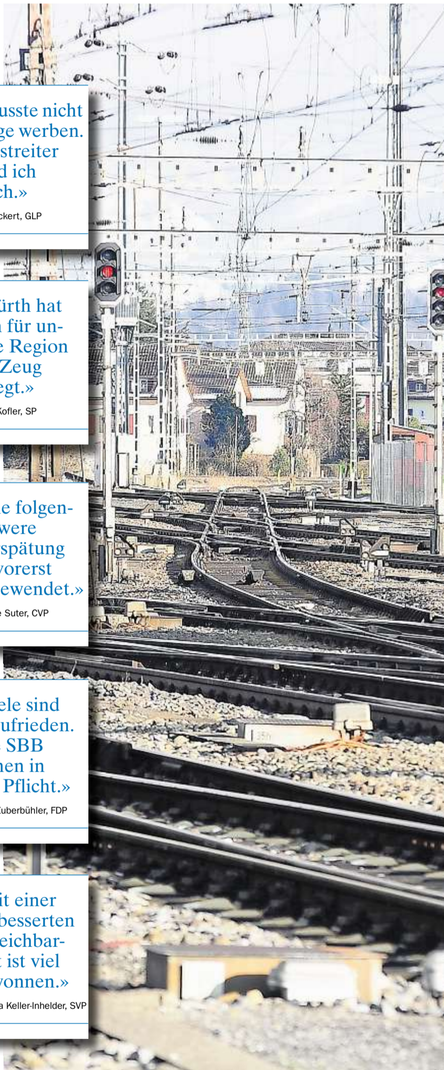
Die SBB versuchen, die Umsetzung des Halbstundentakts im Linthgebiet beschleunigt umzusetzen. Anfang März legen sie einen neuen Terminplan vor. Bild: Kurt Heuberger
