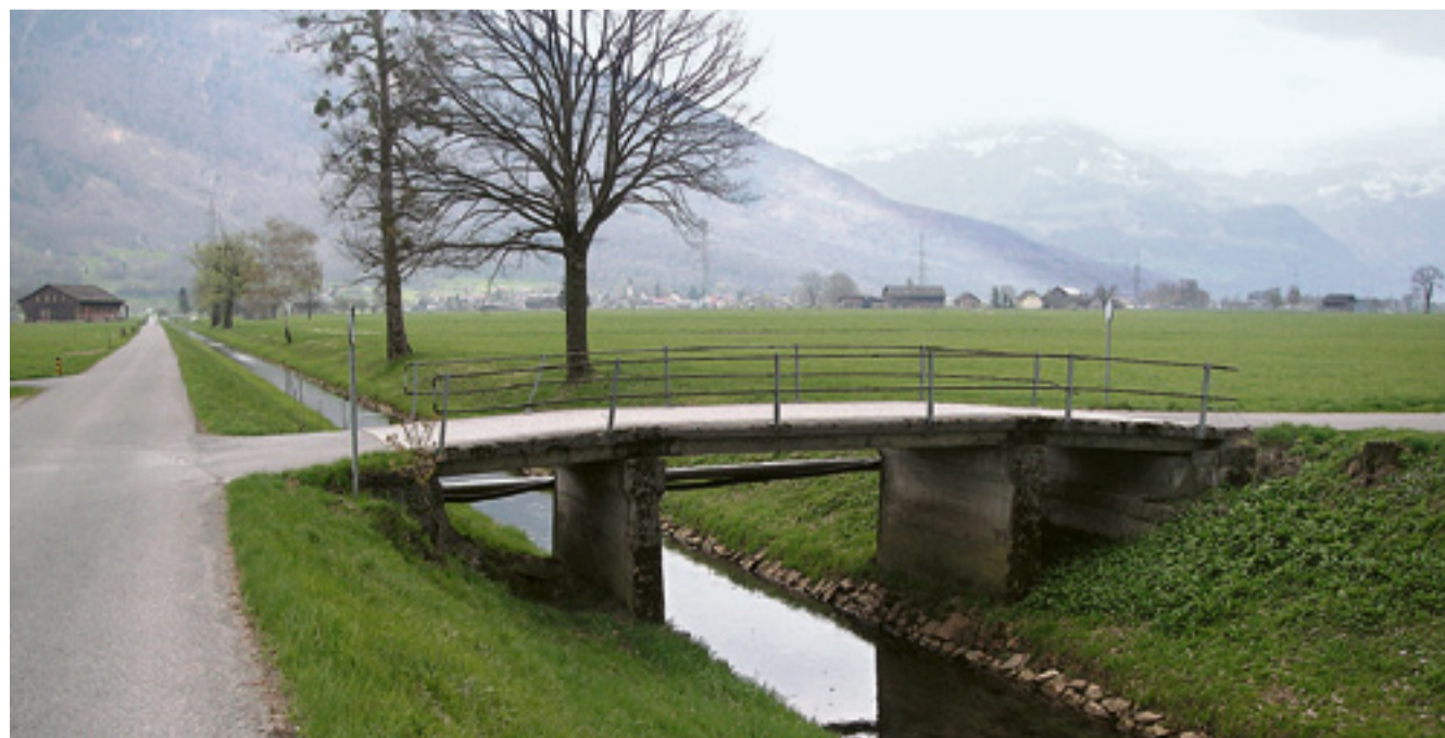
Die alte Selletgrabenbrücke wird ersetzt. Bild: zvg
