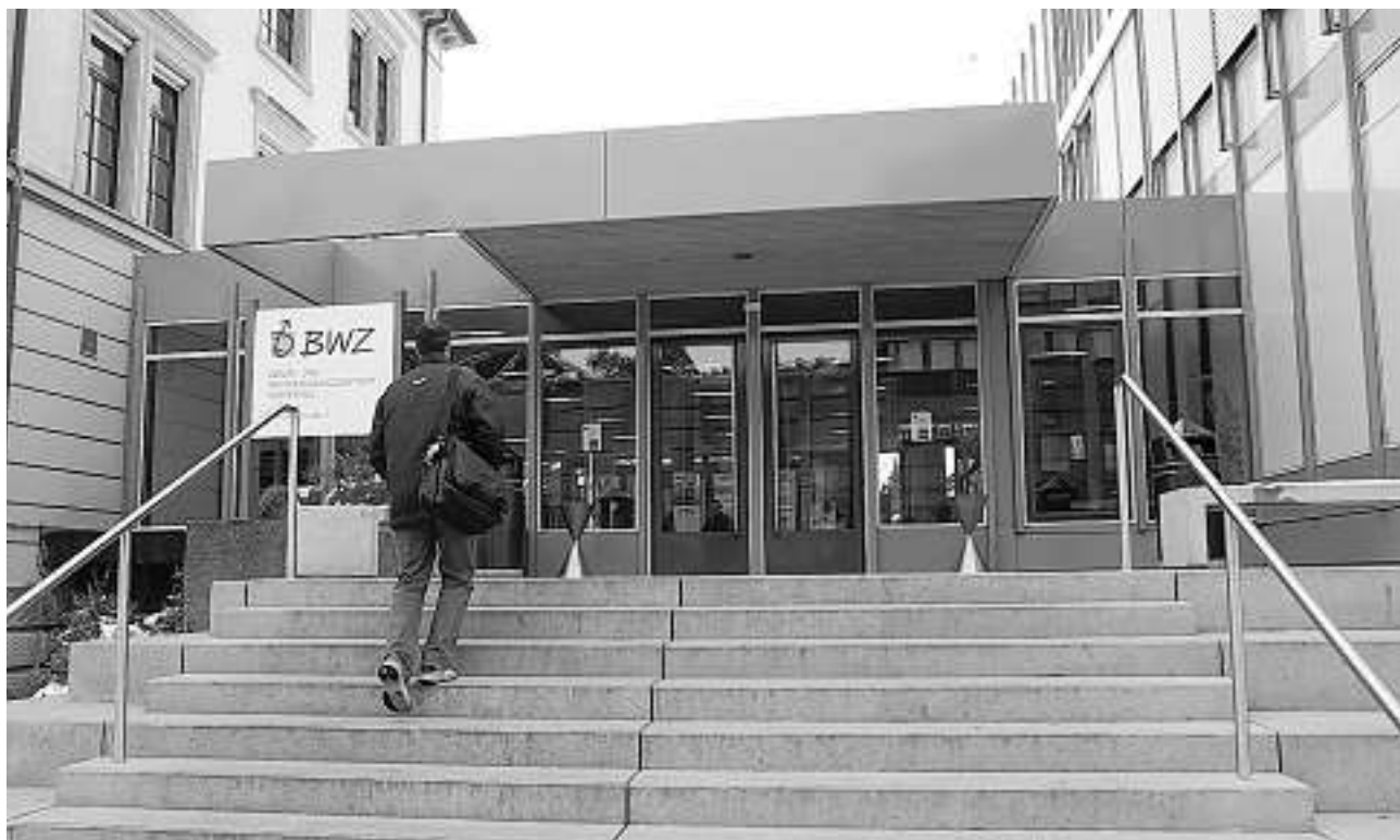
Nichts Neues: Geht es nach der Regierung, bleibt das BWZ noch für die nächsten 20 Jahre an der Zürcherstrasse.
