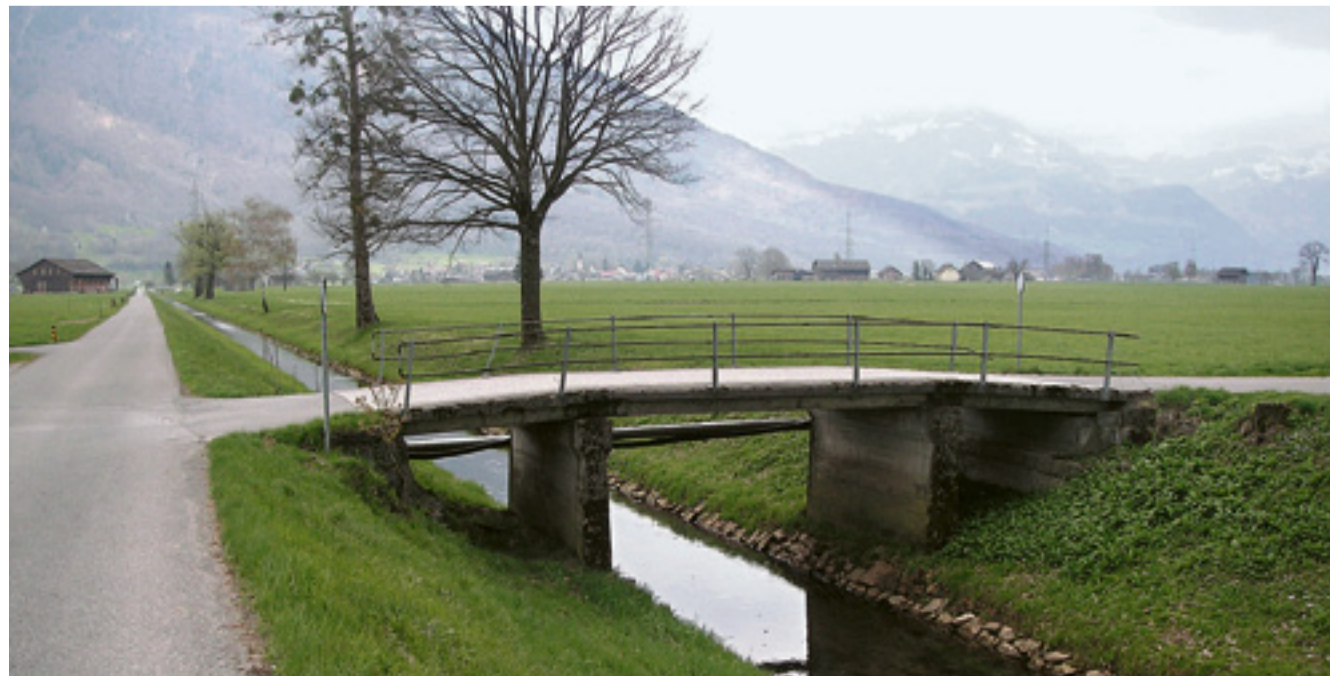
Die alte Selletgrabenbrücke wird ersetzt. Bild: zvg
